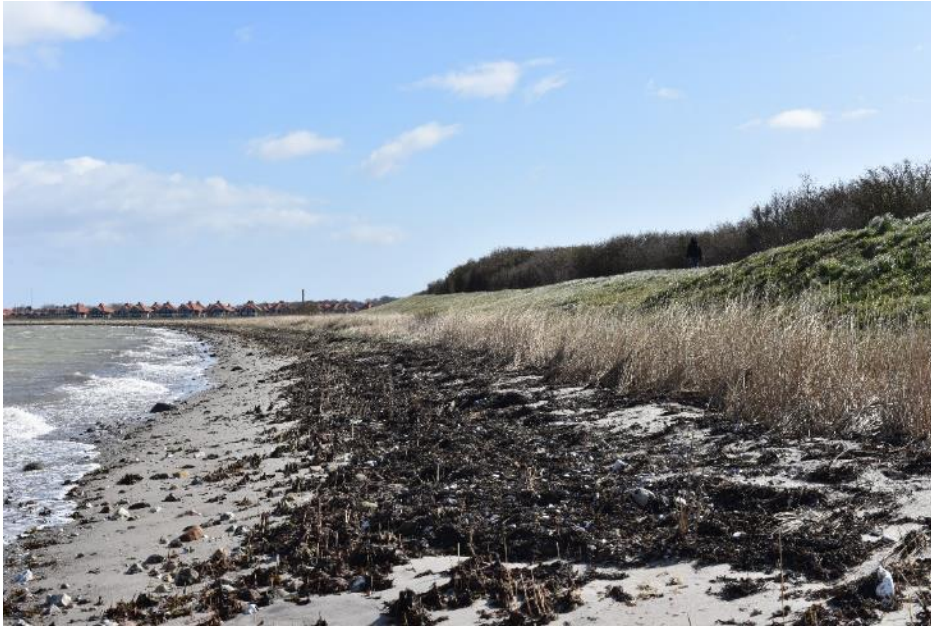
Figur 3-7 Foto: Strækning 5, eks. dige mod nordøst (Foto WSP)
