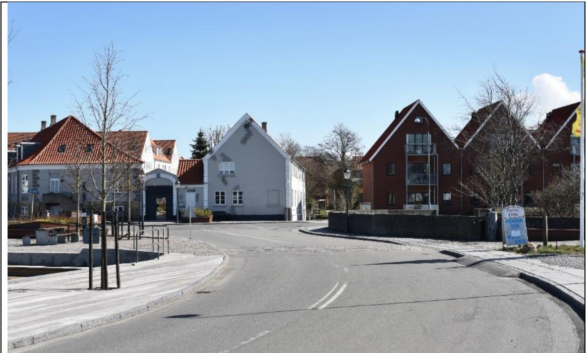
Figur 14-33: Fotostandpunkt 3 – Eksisterende forhold
