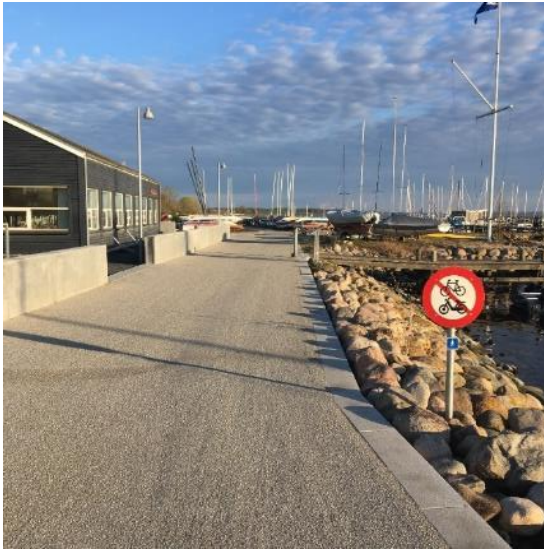
Figur 1-5 Inspiration til løsning ved Strækning 7 fra Roskilde Havn med permanent betonmur med åbninger til mobile skot, Foto: WSP
