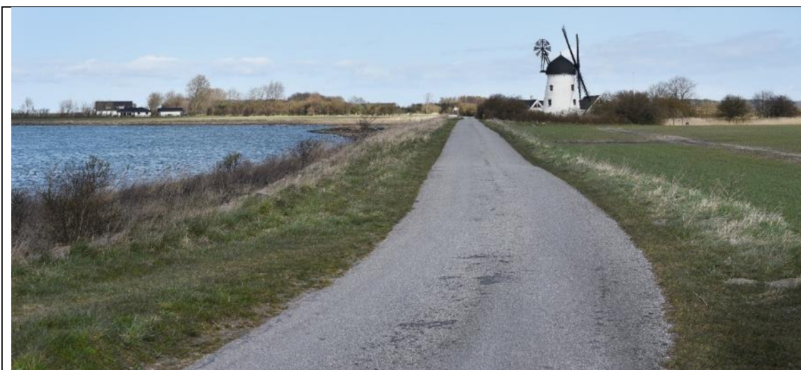
Figur 14-29: Fotostandpunkt 7 – Eksisterende forhold
