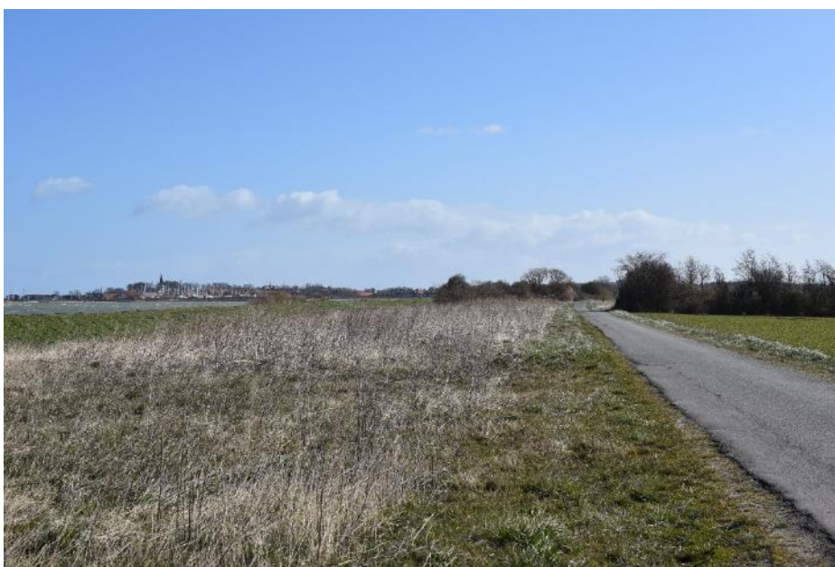
Figur 3-6 Foto: Strækning 4, eks. dige mod nordøst (Foto WSP)
